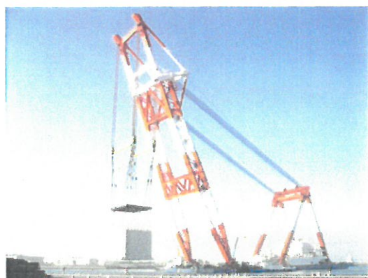
ケーソン吊上げ：西浜ヤード
