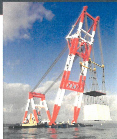
ケーソン据付
